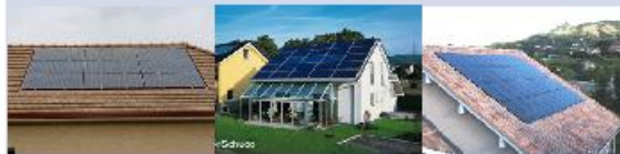
Modules au silicium monocristallin (gauche), multicristallin (milieu) et en couche-mince (droite) intégrés en toiture
