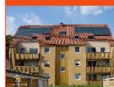
CESC intégré en toiture d'un logement collectif
