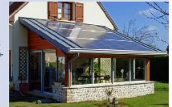
Veranda photovoltaïque à modules semi-transparents au silicium en couche-mince
