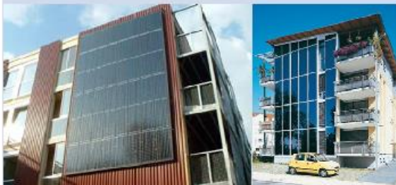
Bardage solaire en modules au silicium en couche-mince (façade noire et bleue)
