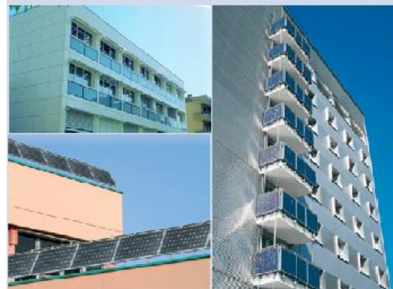
Garde-corps photovoltaïques de fenêtre au silicium en couche-mince (haut gauche), de toiture-terrasse au silicium monocristallin (bas gauche) et sur balcon au silicium multicristallin (droite)
