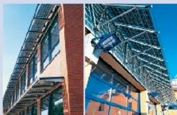
Brise-soleil à modules semi-transparents au silicium monocristallin
