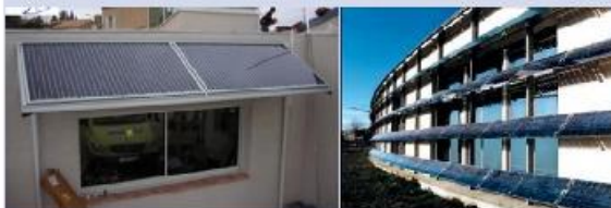
Brise-soleil à modules classiques au silicium monocristallin (gauche) et multicristallin (droite)
