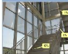
Caractéristiques de transparence des modules semi-transparentes au silicium en couche-mince
