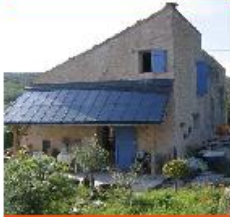
Illustrations de SSC intégré en toiture (haut) et de PSD en brise-soleil (bas)
