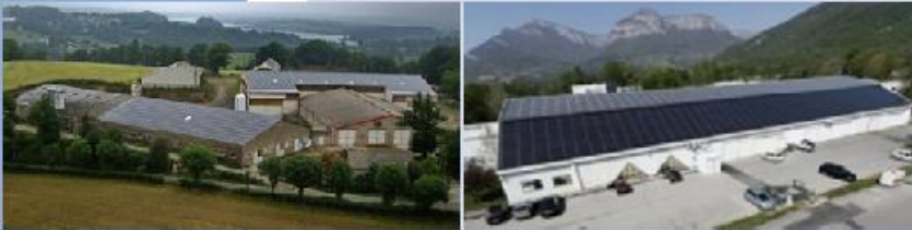
Modules photovoltaïques en toiture d'une exploitation agricole à Salles-Curan (12) (gauche) et en toiture d'un complexe sportif à Challes-les-Eaux (73) (droite)
