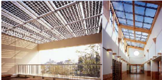
Toitures semi-transparentes au silicium cristallin (gauche) et en couche-mince (droite)
