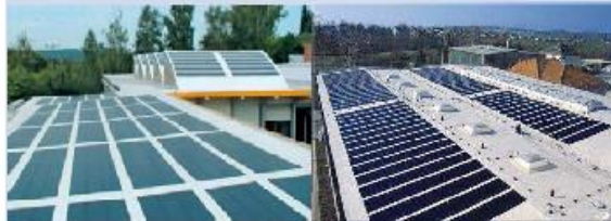
Toitures-terrasses recouvertes de membranes d'étanchéité photovoltaïques
