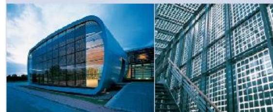
Murs-rideaux en modules au silicium multicristallin
