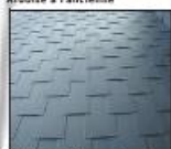
Ardoise fraîchement posée
