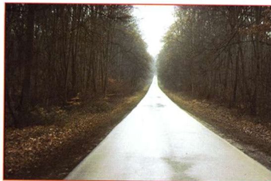
Un revêtement bitumineux noir, rendu brillant par la pluie, contraste très fortement avec le milieu forestier. En plus, la nature de la couche de roulement incite à la vitesse.
