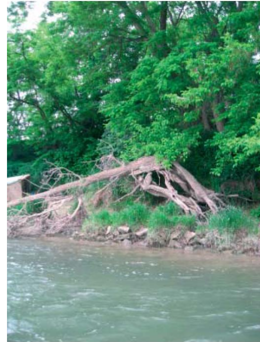
Arbre en voie de déracinement, mettant en péril les berges
