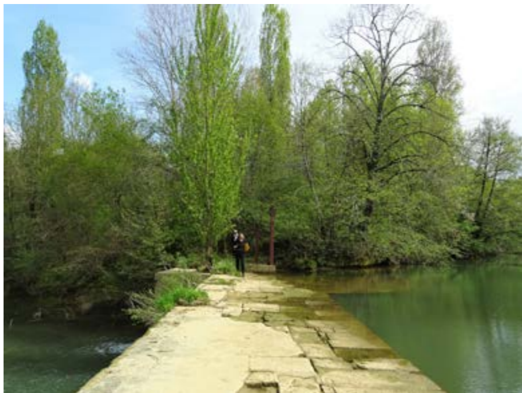
La chaussée dans son écrin végétal, au départ du canal d'amenée au moulin de l'abbaye ; c'est un des édifices fondateurs de l'histoire de Valence-sur-Baïse, à restaurer et valoriser.
