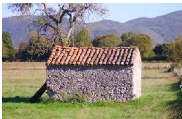
▼ Abri agricole, adossé à des éléments arborés crédit photo : Chambre d'agriculture de Haute-Garonne
