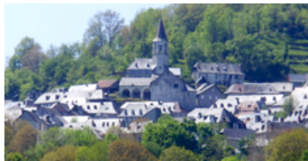
Opération ardoise en Couserans - Exemple d'utilisation de la ressource locale - Village de Galey (Ariège).
