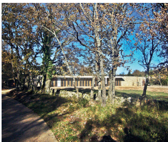
❑ Le restaurant – maison de site au fond de la doline : une architecture contemporaine qui s'inscrit dans l'identité du causse.
