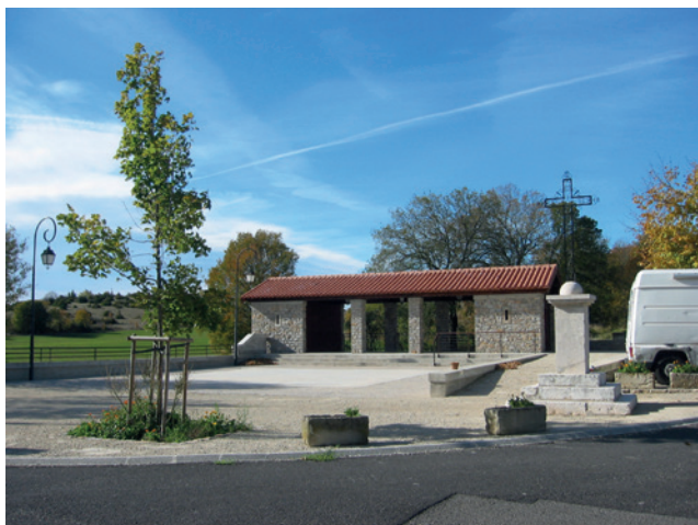
□ Place aménagée intégrant un bâtiment (local technique et toilettes), valorisant l'entrée du village et apportant un confort apprécié des habitants et des visiteurs.
