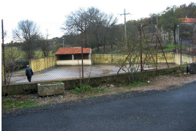
□ Ancien réservoir d'eau au cœur de Sorbs, face à l'église, avant réhabilitation.
