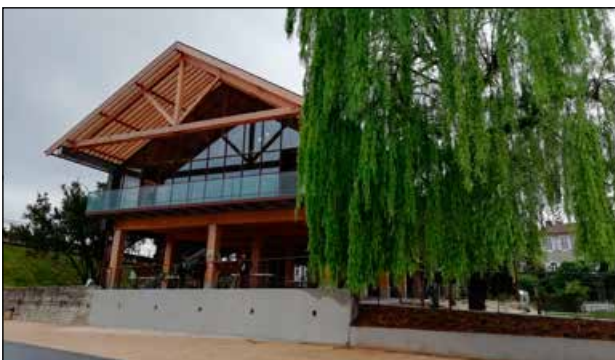
L'ancien hangar à bateaux réhabilité
