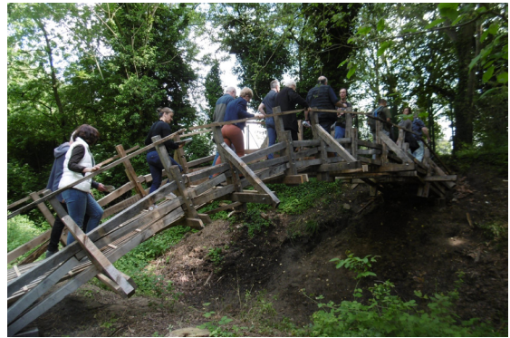
Passerelle en grumes d'aulne façonnée dans le cadre d'un chantier participatif avec les habitants. Crédits : D. Delbaere
